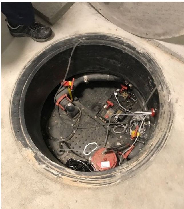
Etablering af højvandslukker i afd. 120, Niels Juels Gård. Foto: VIBO
