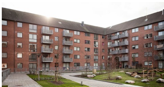
Afdeling 140 - Televænget II.
